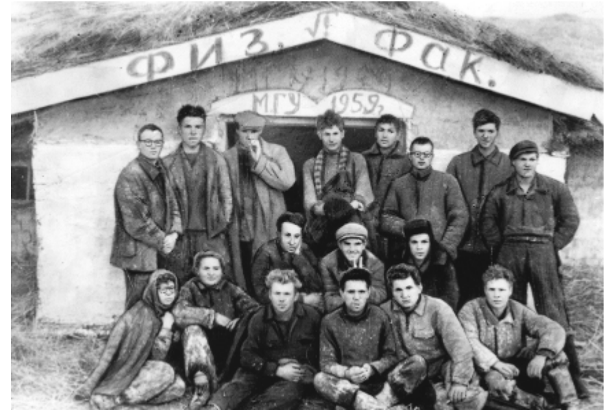
Бойцы первого строительного Физического факультета МГУ у построенной кошары в Булаевском совхозе Сев. Казахстанской области, 1959 г.
